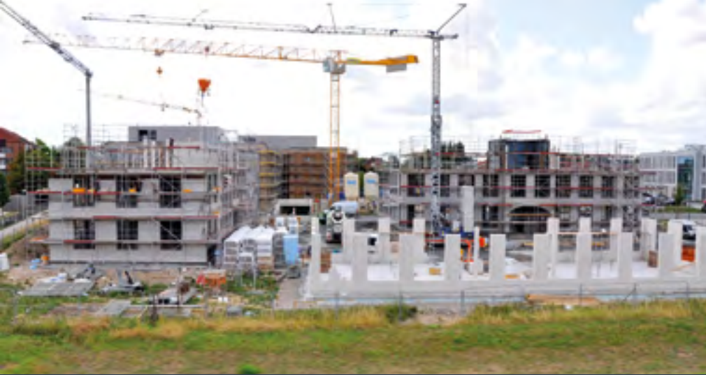
Im Technologiepark Münster werden zurzeit der R&D-Campus (Vordergrund) und der Wilhelm-Schickard-Campus (Hintergrund) realisiert.
